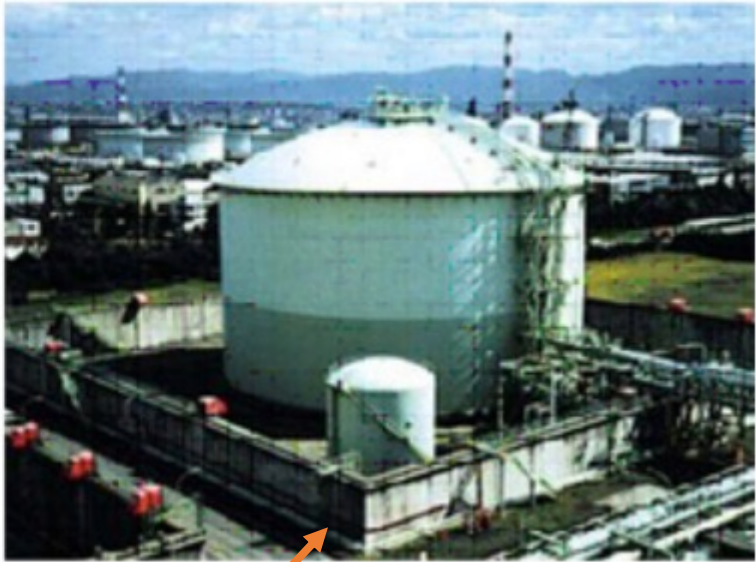
Double-walled metal LNG tank
